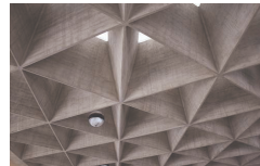
Die dak van 'n lughawe waar die struktuur versterk word deur die gebruik van driehoekvorme wat baie sterk is.
