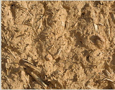
'n Naby-foto van die modder wat gebruik is om die muur te maak.
