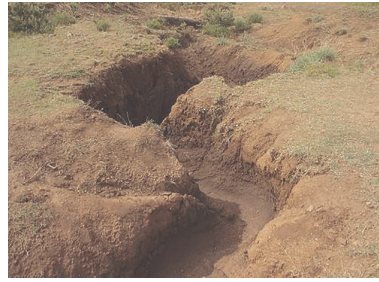
Gronderosie deur water. 2
