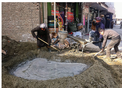
Bouers meng beton deur grawe te gebruik.
