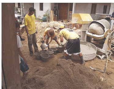
Bouers meng beton met 'n menger.
