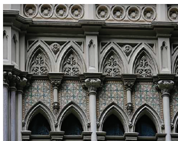
Dekoratiewe snywerk en pilare van sandsteen op 'n gebou. 11
