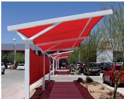
Figuur 5.38 Drie verskillende vrydraers: om die skadunet te steun; om 'n sonkap oor 'n deur te steun; as deel van 'n voorafgegote bruggedeelte
