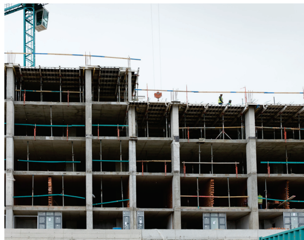
Figuur 3.20b Pilare van 'n betonraamgebou
