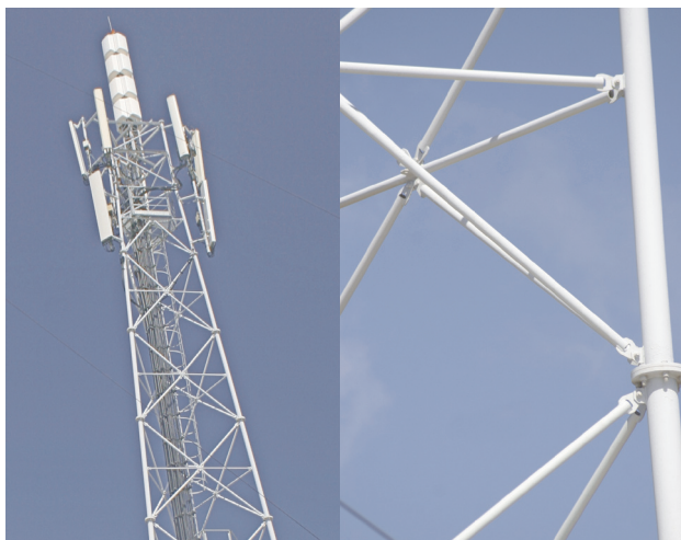
Figuur 3.20a Die staalpilare van hierdie selfoontoring is swaarder as al die ander dele
