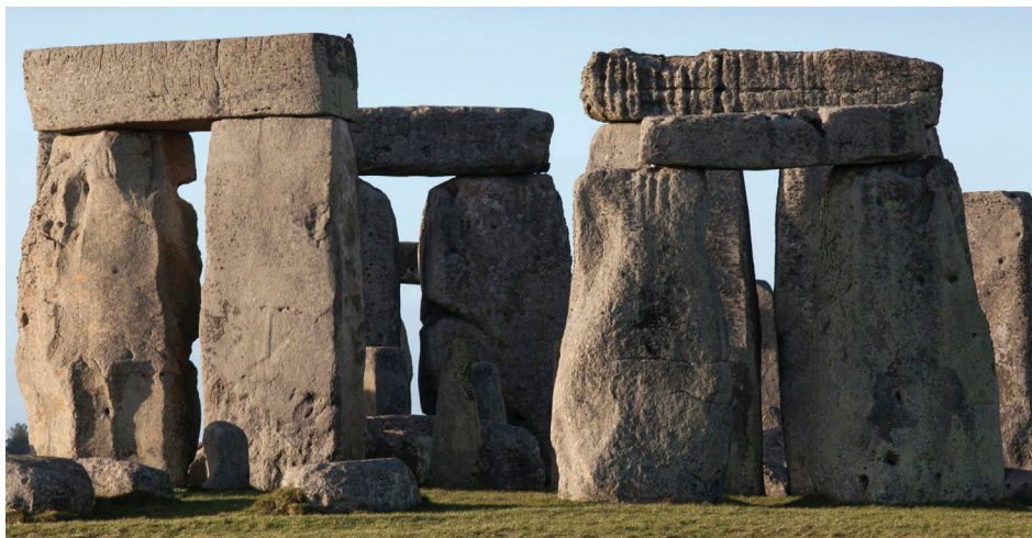
Figuur 5.8 Antieke balke was gewoonlik eenvoudig ondersteun.
