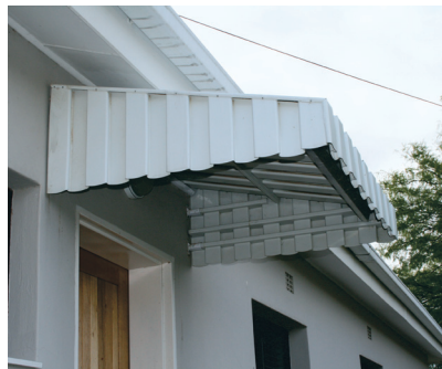
Figuur 5.38 Drie verskillende vrydraers: om die skadunet te steun; om 'n sonkap oor 'n deur te steun; as deel van 'n voorafgegote bruggedeelte
