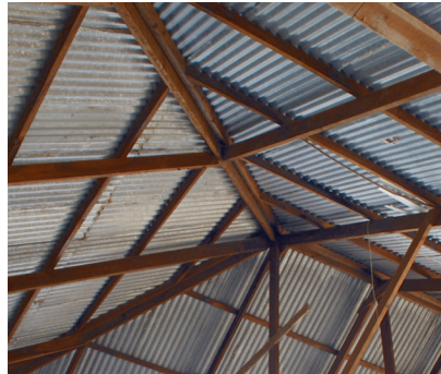
Figuur 3.24b Houtkaplatte wat 'n sinkdak stut
