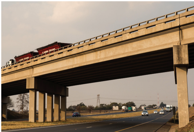
Figuur 5.10a Eenvoudig-ondersteunde balke in 'n brug
