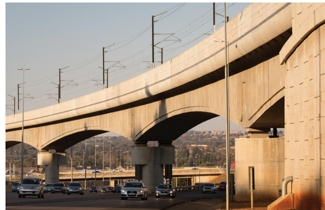
Figuur 5.9d Daar is 'n laer tussen elkeen van hierdie steunkolomme en die brugstruktuur bo.
