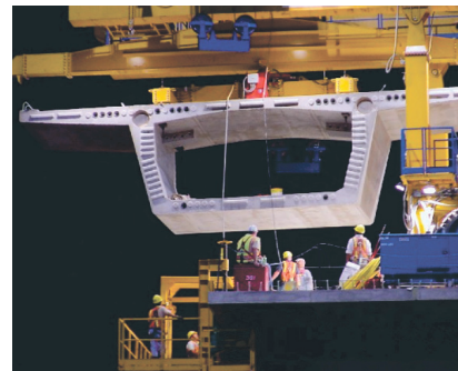
Figuur 5.38 Drie verskillende vrydraers: om die skadunet te steun; om 'n sonkap oor 'n deur te steun; as deel van 'n voorafgegote bruggedeelte
