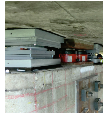
Figuur 5.9d Daar is 'n laer tussen elkeen van hierdie steunkolomme en die brugstruktuur bo.
